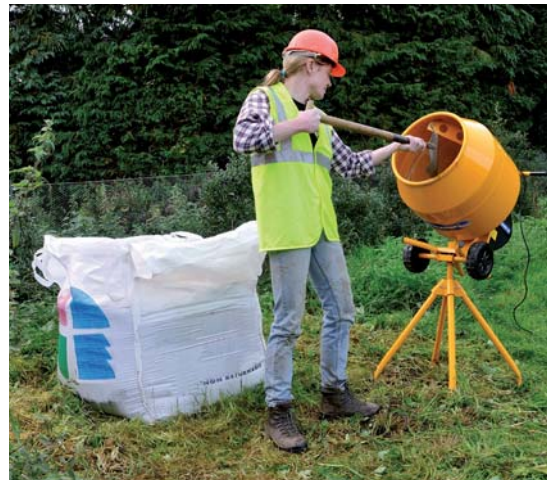
Me përzierjen e rërës, çimentos dhe ujit fitohet llaçi
